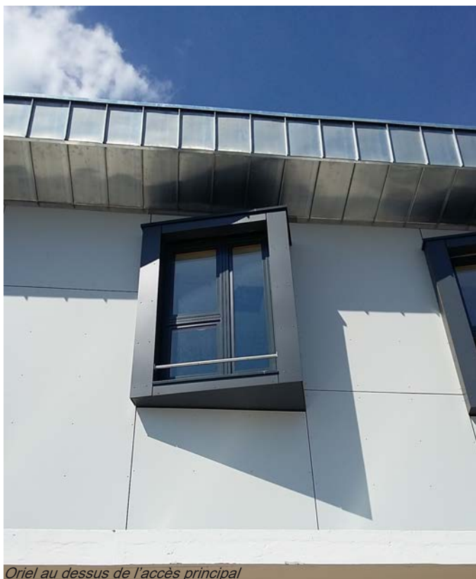
Oriel au dessus de l'accès principal
