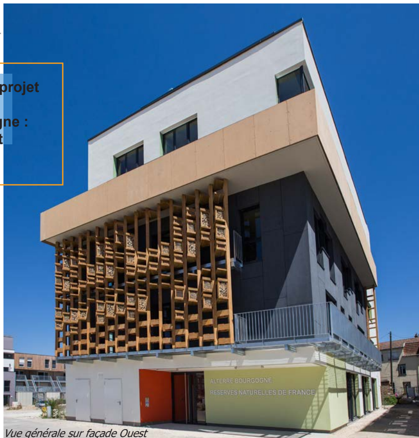
Vue générale sur façade Ouest
