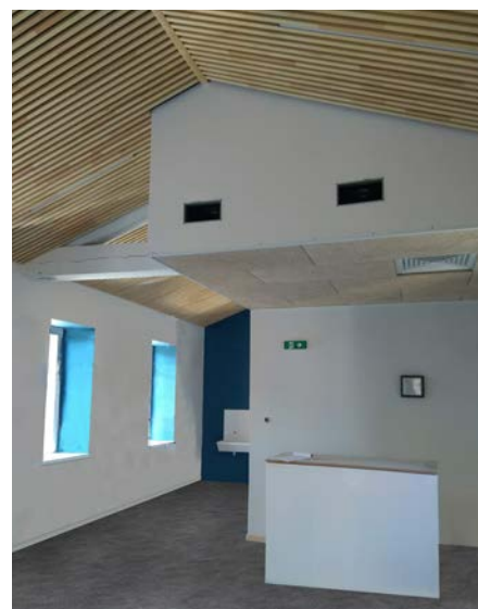
Photo chantier en cours
